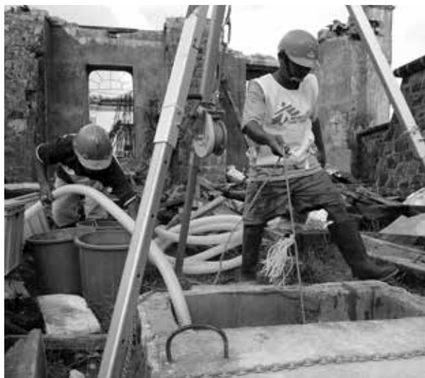
Čištění studny po tajfunu
